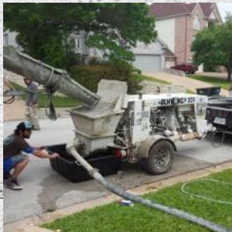
Es muy importante contar con una zona de desperdicio o escombro en la obra para que los equipos, bomba pluma y camión revolvedor laven los residuos del colado, esta zona será provista por el contratista, constructor o cliente.
