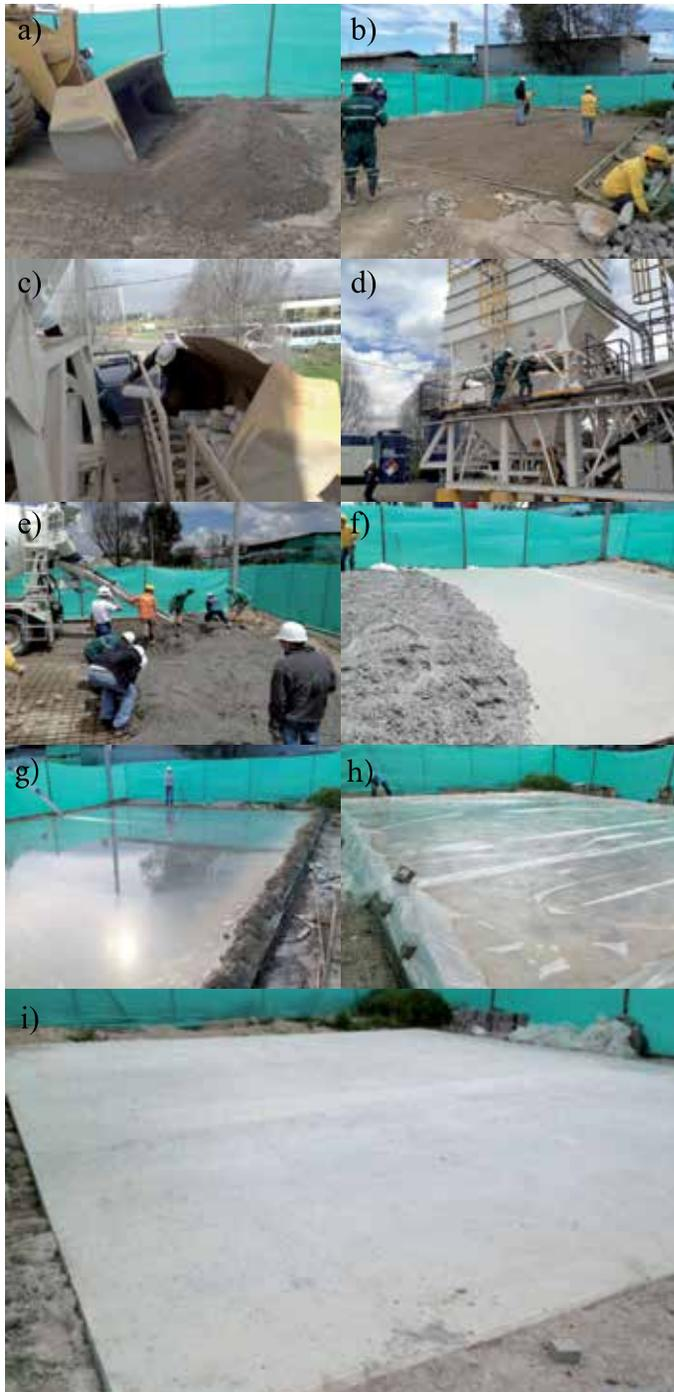
Figura 10: Imágenes del proceso constructivo de la prueba piloto, a) preparación del terreno, b) colocación de moldaje perimetral, c) descarga de cemento, d) planta de concreto, e) vertido de concreto, f) nivelado, g) piscina de saturación, h) retención de la humedad e i) estado final
