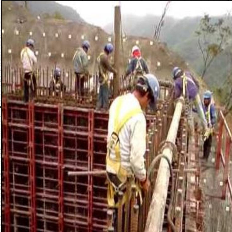
9° El manejo, montaje y desinstalación de la tubería de la bomba de concreto, será dirigido por un especialista en seguridad que revise y prevea la formación de obstrucciones internas.
